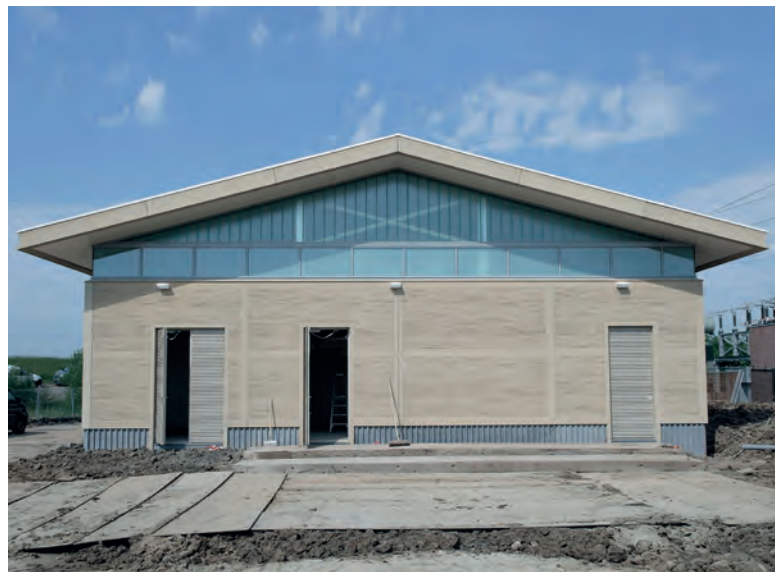
50kV station Ooltgensplaat
