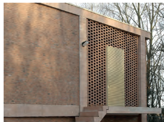
architectuur dmv metselwerk en prefab details
